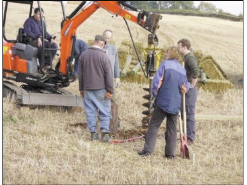
↑2. Следващата стъпка е да използваме малък трактор за издълбаване на дупките за рециклираните телеграфни стълбове, на които ще се издигне платформата.
